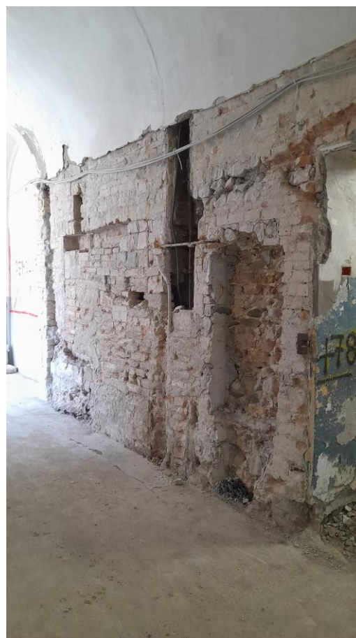
Nicchie e aperture tamponate sulla muratura del corridoio risultanti a seguito della rimozione delle finiture
