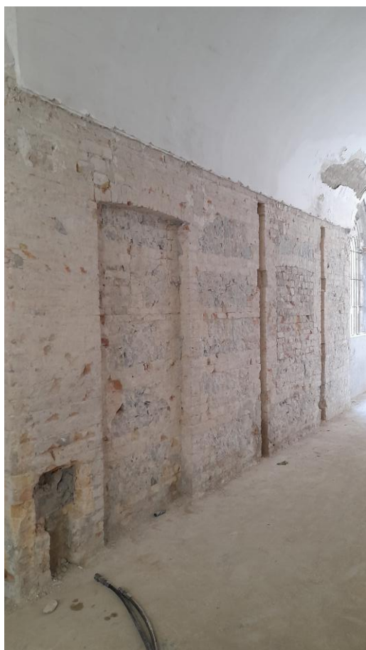
Nicchie e aperture tamponate sulla muratura del corridoio risultanti a seguito della rimozione delle finiture
